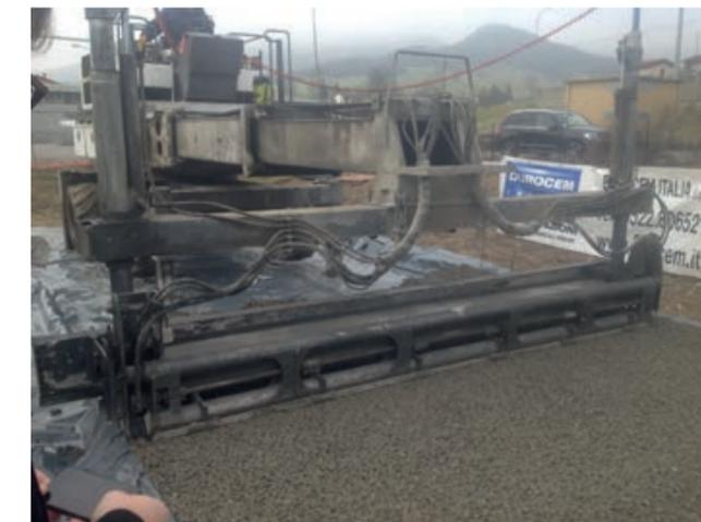
Questa operazione ha la durata di circa una settimana e dopo tre giorni di maturazione è possibile iniziare le operazioni di posa del manto di erba sintetica senza ulteriori operazioni di sabbatura e sistemazione, transitando direttamente coi mezzi necessari (autocarri, palette gommate, ecc.) sul massetto.
