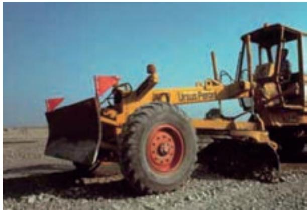
Esecuzione sottofondo
