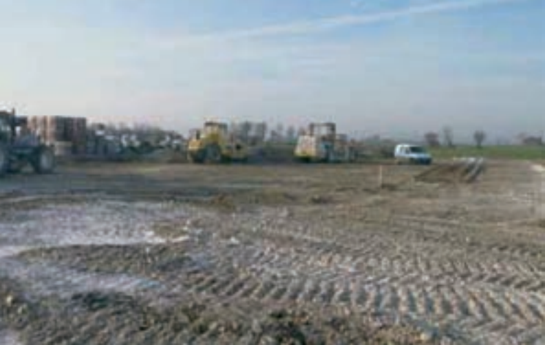
Bonifica e stabilizzazione con calce
